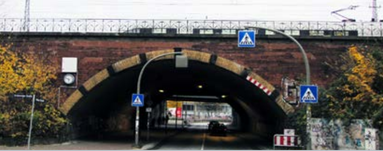
Wird neu gebaut: Die Eisenbahnbrücke Plöner Straße
