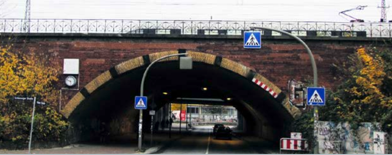
Wird neu gebaut: Die Eisenbahnbrücke Plöner Straße
